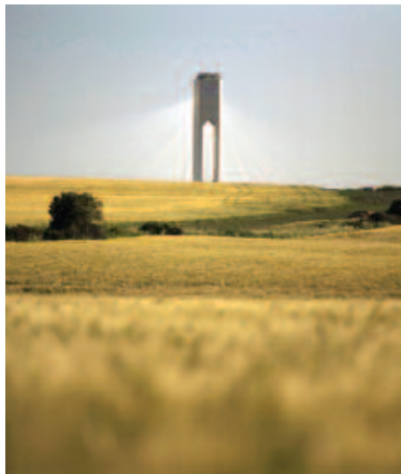
Vista dell'alta torre di 115 metri presso la Centrale termale PS10 a Siviglia, in Spagna. Sotto questa torre, 624 specchi mobili chiamati Eliostati concentrano i raggi del sole verso la sommità della torre, dove sono collocati un ricevitore solare e una turbina a vapore. La turbina aziona un generatore, producendo energia elettrica.
